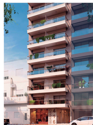
Serrano 416 Villa Crespo - CABA 1, 2 y 3 ambientes EN EJECUCIÓN
